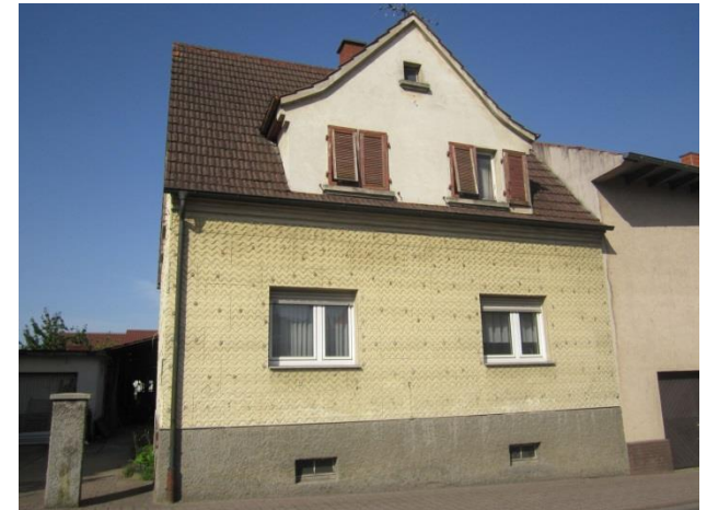
Erhebliche Mängel, Östringer Straße 34
