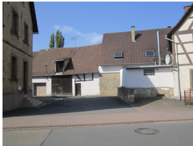
Erhebliche Mängel, Östringer Str. 4
