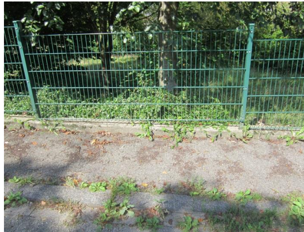
Gestaltungsmängel Gehweg, Bergstraße
