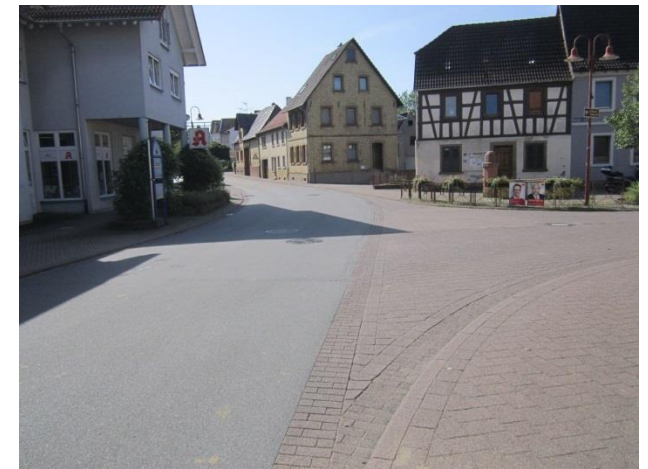
Fehlende Querungsmöglichkeit, Östringer Straße
