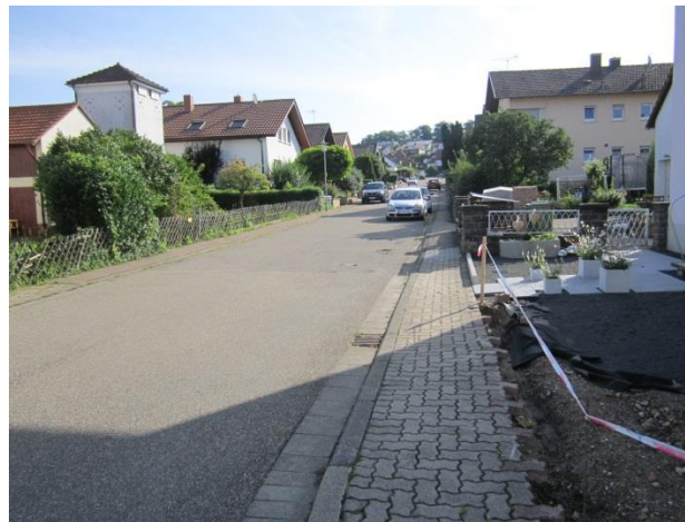
Schmale Gehwege, Nelkenweg
